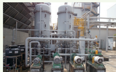
廃水処理設備
