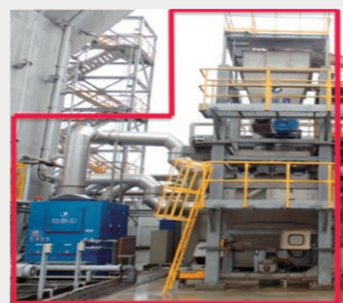
スラッジ乾燥処理設備
